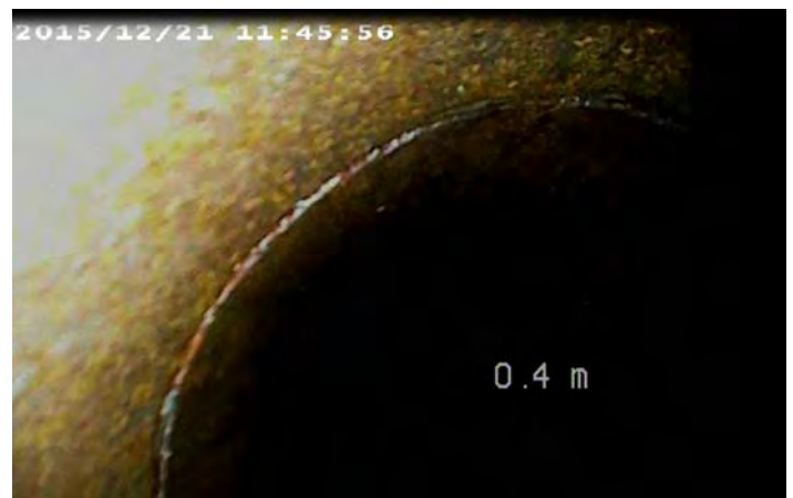
Efter ca 0,4 m., skarv på skyddsroret
