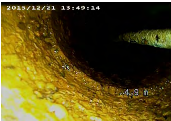
Efter ca 4,9 m ser vi en tydlig kant. Vi tolkar det som skyddsrörets slut.
