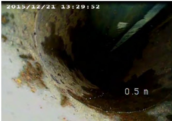
Efter ca 0,5 m, skarv på skyddsroret
