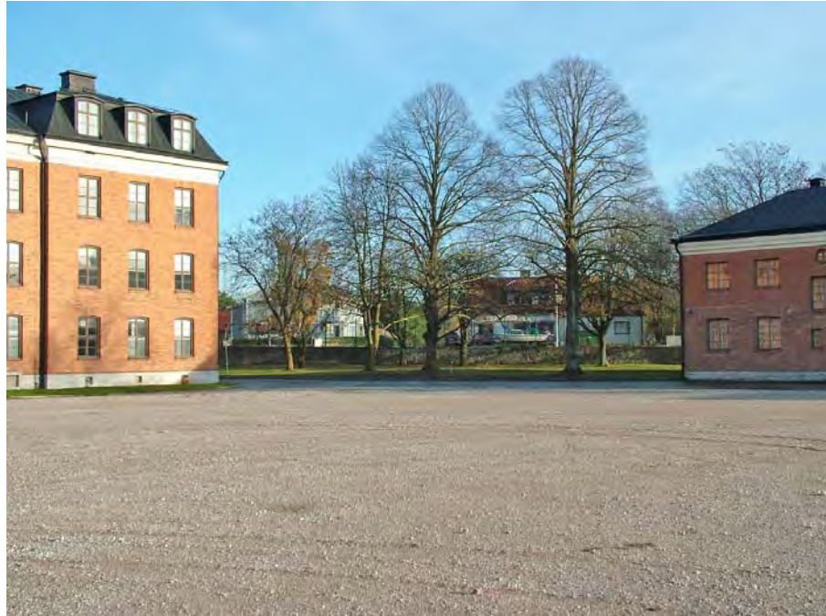
Vy från den öppna kaserngården mot nordost.
