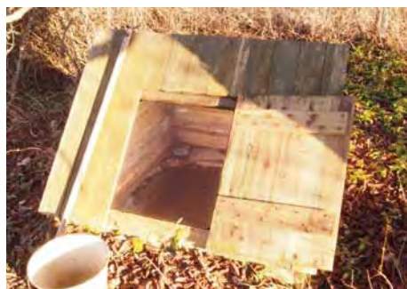
Grävd brunn där ytvatten rinner rakt in.
