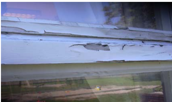
Bild nr 3: Fönster vid Eksta skola
